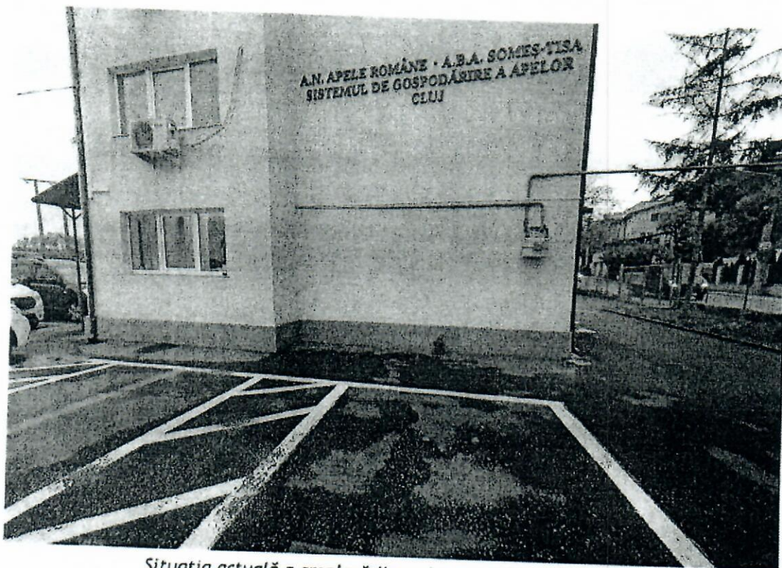
Situația actuală a amplasării conductei de gaz (Foto 18.04.2024)
