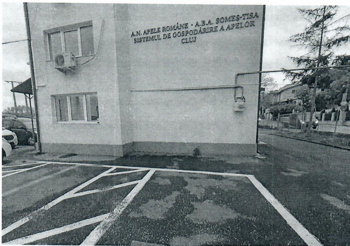
Situația actuală a amplasării conductei de gaz (Foto 18.04.2024)
