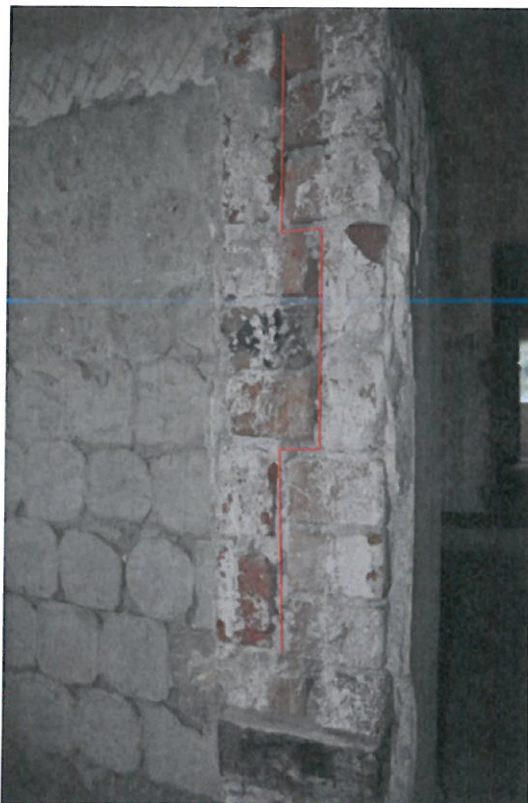
Fig. 1 – Aspect zidărie pereți structurali la etaj
