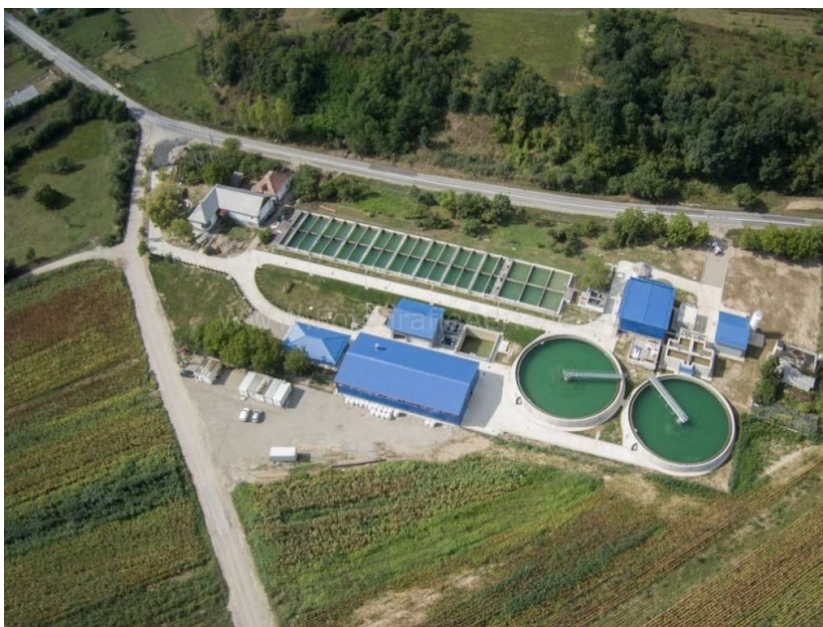
Stația de epurare de la Beclean. Sursa foto: https://fotografieaeriana.eu/
