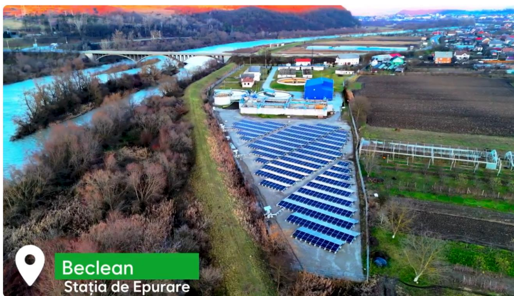
Stația de epurare de la Beclean. Sursa foto: www.aquabis.ro
