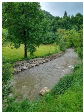
Consolidare vegetativă a râului Someșul Mare, în loc. Șanț (foto 1 – stadiu incipient, foto 2 – stadiu final)
